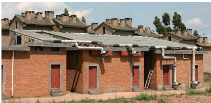
中建热泵助推式太阳能干燥设备案例实景图 1
