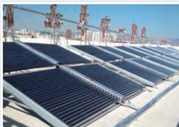
中建真空管太阳能热水器工程案例实景图
