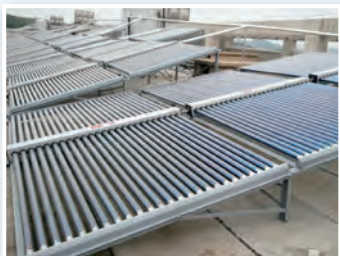
中建真空管太阳能热水器工程案例实景图
