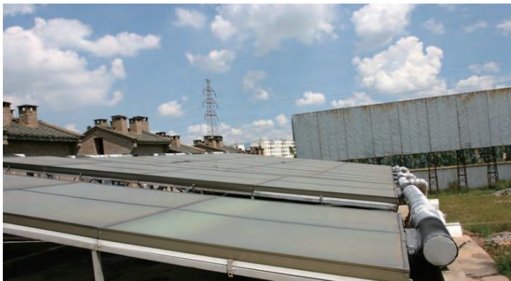
中建热泵助推式太阳能干燥设备案例实景图 2
